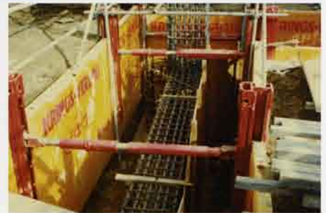
▲コーナー部の施工
