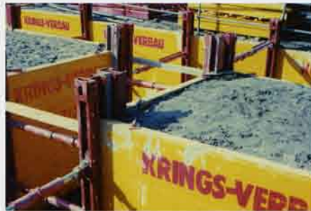
▲井形の土留め
